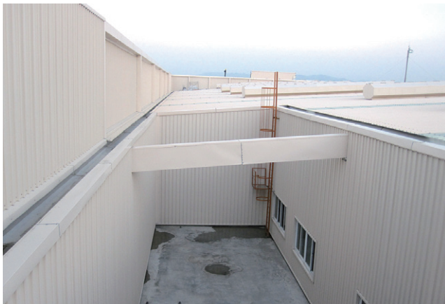
台南市精剛精密科技股份有限公司 鍍層量 Y30，PVDF 塗料 S-Tech Corp., Tainan, Taiwan Coating mass: Y30; paint type: PVDF
