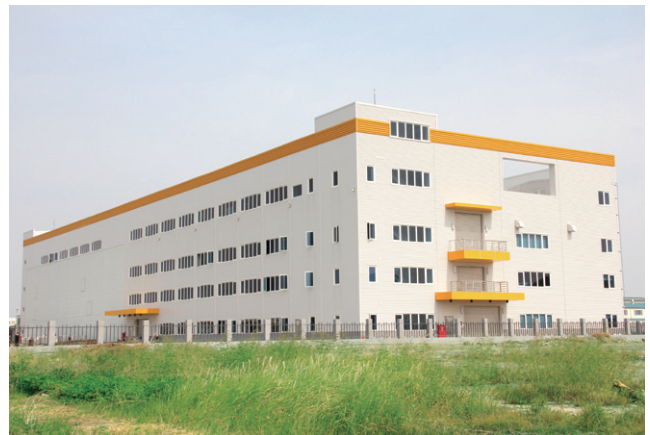
台南市森田印刷廠股份有限公司 鍍層量 Y27，PVDF 塗料 Sentien Printing Factory Co., Ltd., Tainan, Taiwan Coating mass: Y27; paint type: PVDF
