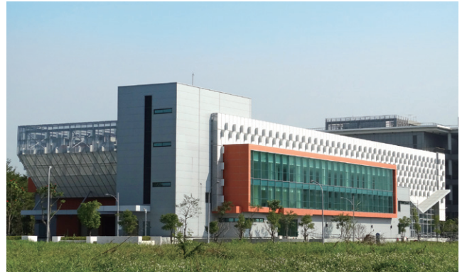
屏東農業生物科技園區 鍍層量 Y30，PVDF 塗料 Pingtung Agricultural Biotechnology Park, Pingtung, Taiwan Coating mass: Y30; paint type: PVDF
