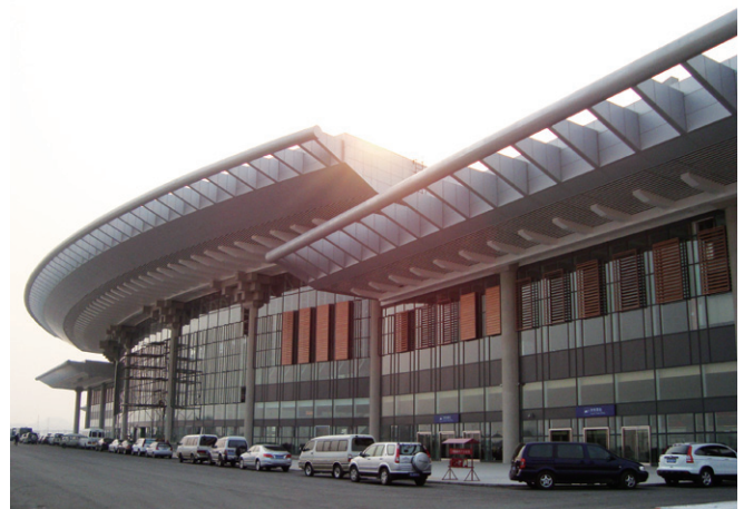
中國大陸福州高鐵站 使用燁輝(中國)熱浸鍍 5% 鋁-鋅鋼板 China High-Speed Railway--Fuzhou Station Hot-Dip 5% Al-Zn Coated Steel
