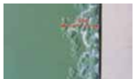
鍍 55% 鋁鋅 PVDF 烤漆鋼捲 (經過鹽霧試驗 3000 小時後) 邊緣處有起泡腐蝕 / 距邊 15mm
