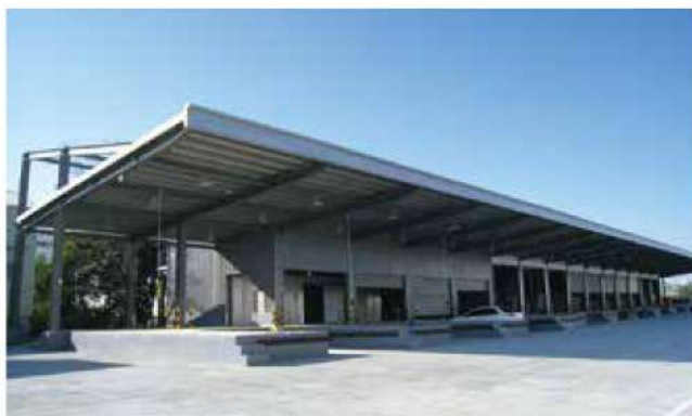
高雄市大社區台灣菸酒公司發貨中心 鍍層量 Y30，SMP 塗料 Distribution center of Taiwan Tobacco & Liquor Corp., Kaohsiung, Taiwan Coating mass: Y30; paint type: SMP
