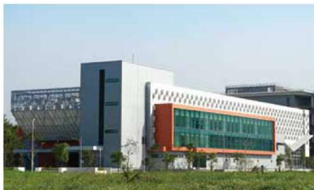
屏東農業生物科技園區 鍍層量 Y30，PVDF 塗料 Pingtung Agricultural Biotechnology Park, Pingtung, Taiwan Coating mass: Y30; paint type: PVDF
