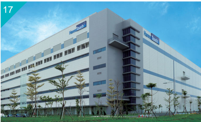
台南和鑫光電(股)公司 -- 南科廠屋頂 / 外牆，PVDF 烤漆鋼板 經銷 / 翦茂金屬(股)公司，承造 / 圓加有限公司 Roofing/Siding of HannsTouch Solution Incorporated--Tainan Feb 2, Tainan, Taiwan Paint Type: PVDF
