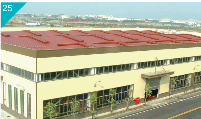
高雄市光陽工業(股)公司屋頂，SMP 烤漆鋼板 Roofing of Kwang Yang Motor Co., Ltd., Kaohsiung, Taiwan Paint Type: SMP
