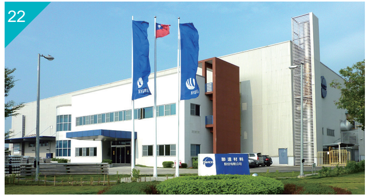
雲林聯達材料(股)公司屋頂 / 外牆，PE 烤漆鋼板 Roofing/Siding of Formosa Alloy Material Co., Ltd., Yunlin, Taiwan Paint Type: PE
