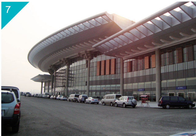
7 中國大陸福州高鐵站 使用燐輝(中國)熱浸鍍5%鋁鋅鋼板 China High-Speed Railway--Fuzhou Station Hot-Dip 5% Al-Zn Coated Steel Sheet
