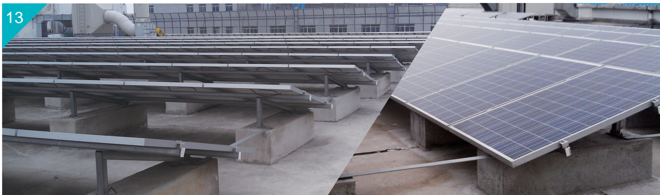
太陽光電支架 熱浸鍍 5% 鋅、鋁鎂鋅鋼板 Solar Panel Bracket Hot-Dip 5% Al-Zn / Zn-Al-Mg Coated Steel Sheet
