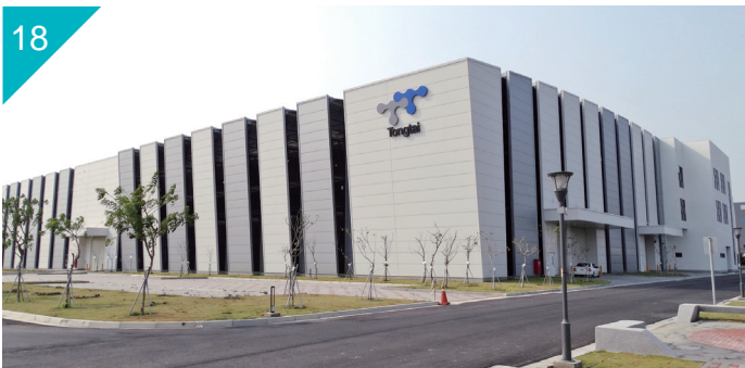
高雄科學園區東台精機(股)公司室外三明治板 潔淨節能(3C)高耐磨耗(RA)及高耐磨耗(RA) PVDF 烤漆鋼板 Sandwich Panels for Outdoor Use at Tongtai Machine & Tool Co., Ltd., Kaohsiung Science Park, Taiwan Paint Type: RA PVDF & 3C-RA PVDF
