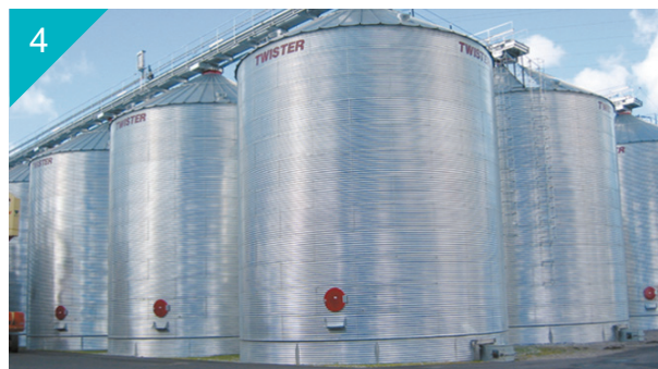
4 穀物筒倉，鍍 5% 鋁鋅鋼板 照片由加拿大 Twister Pipe 公司提供 Grain Bin, Hot-Dip 5% Al-Zn Coated Steel Sheet Courtesy of Twister Pipe Ltd., Canada
