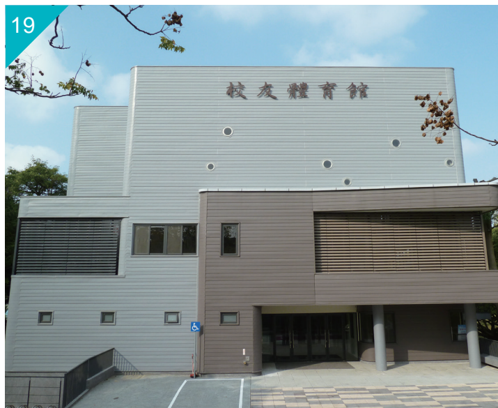
台灣清華大學校友體育館屋頂 / 側牆，PVDF 烤漆鋼板 經銷 / 翦茂金屬(股)公司 承造 / 春野工程有限公司 Roofing/Siding of Alumni Gym, National Tsing Hua University, Hsinchu, Taiwan Paint Type: PVDF
