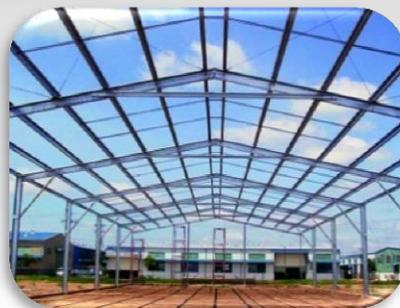
C、Z輕型鋼桁
