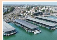
台南安平碼頭(地面型) 光支彩烤漆鋼板
