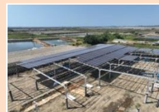
台南室內養殖場(地面型) 光支彩烤漆鋼板
