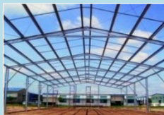
C、Z 輕型鋼桁
