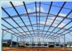
C、Z 輕型鋼桁
